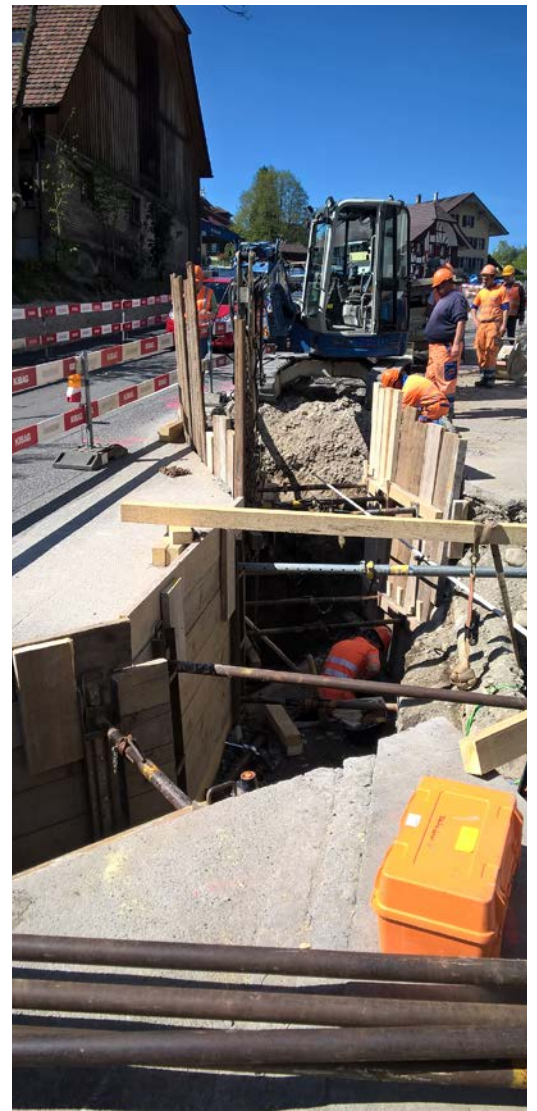
Kanalisationsbaustelle mit gespriesstem Graben
