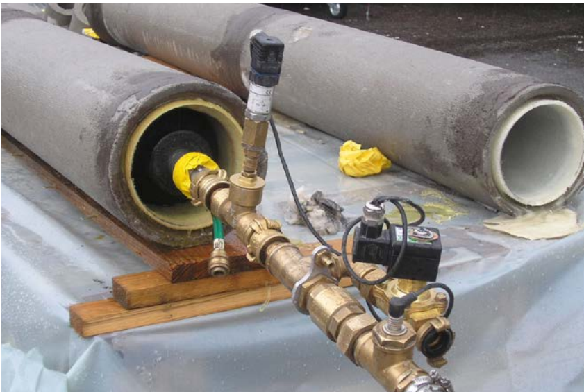
Dichtheitsprüfung mit Luft – Betonrohr mit Schlauchliner
