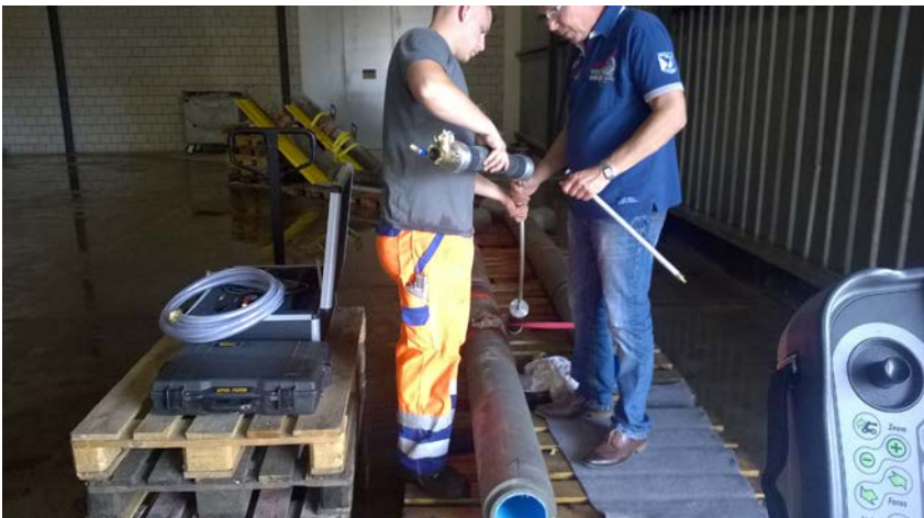
Vorbereiten einer Dichtheitsprüfung mit Packer
