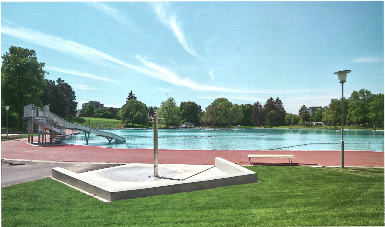
Form und Gestaltung der neuen Duschen entsprechen dem historischen Vorbild, einer Mittelsäule in einer fünfeckigen Fläche. Wo möglich wurden die Duschen an die bauzeitlichen Standorte zurückversetzt. Links im Hintergrund die neue, auf Stahlpfählen fundierte Rutsche. Für die Fundamente wurde die Beckensohle minimal geöffnet.
