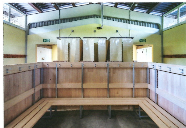
Garderobengebäude Süd: Die ehemalige «Klub- und Lehrer-garderobe» von 1957 wurde renoviert und um einen Kiosk ergänzt. Die Tragkonstruktion des Gebäudes wurde nicht verändert.
