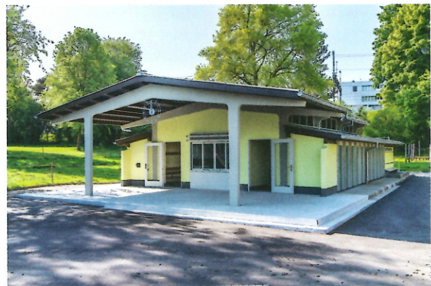
Form und Gestaltung der neuen Duschen entsprechen dem historischen Vorbild, einer Mittelsäule in einer fünfeckigen Fläche. Wo möglich wurden die Duschen an die bauzeitlichen Standorte zurückversetzt. Links im Hintergrund die neue, auf Stahlpfählen fundierte Rutsche. Für die Fundamente wurde die Beckensohle minimal geöffnet.
