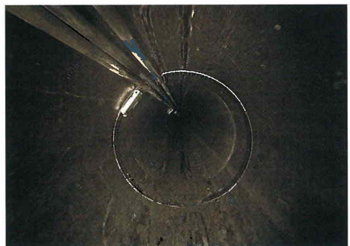
Eingebaute FAST Anlage mit drei Leerröhrchen und Spannring (Bride).
