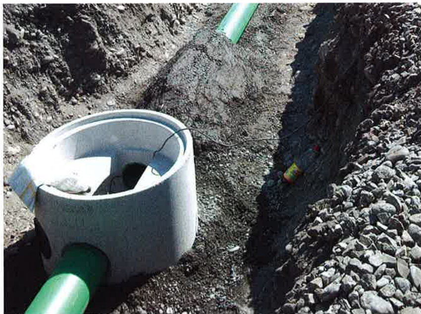
Abb. 1 Fertigschacht aus Beton mit Kunststoffleitung aus Polypropylen (PP).
