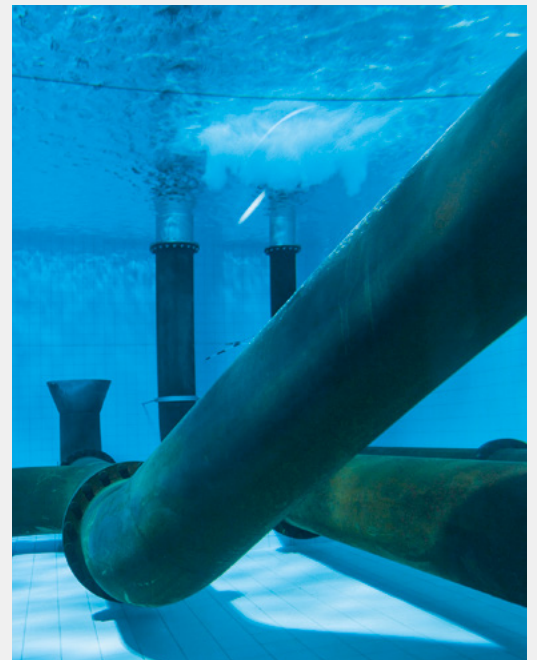
Fig. 6 Zum Schutz des Trinkwassers in der Fassung Worben hat die Standortgemeinde sämtliche Entwässerungsanlagen systematisch untersucht und saniert. (Bild: G. Perrenoud, AWA Bern)
