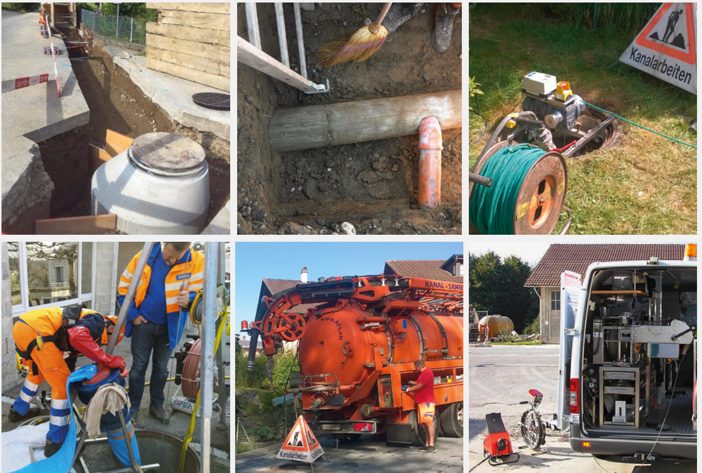
Fig. 8-13 Sanierungen von Abwasserleitungen erfordern nicht immer zwingend Grabarbeiten. Es kommen auch günstigere Techniken infrage. Dazu gehört etwa das Einziehen eines neuen Innenrohrs aus Kunststoff, der im Untergrund aushärtet. (Bilder: Ing.-Büro Hans Ulrich Gränicher Bern)
