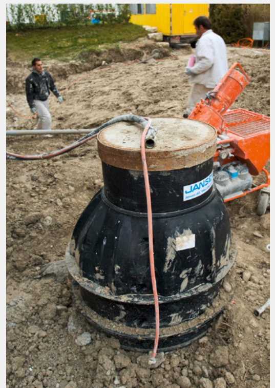
Fig. 7 In der Nähe von Grundwasserfassungen erfordert der Anlagenbau zur Grundstücksentwässerung besondere Sorgfalt. (Bild: G. Perrenoud, AWA Bern)
